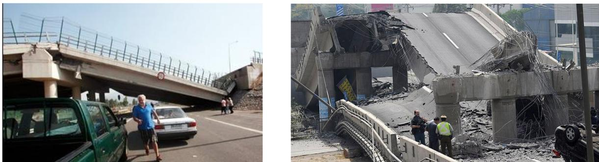
Рис. 3. Разрушение путепровода при землетрясении в Чили.
