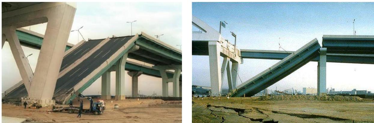
Рис. 1. Разрушение транспортной эстакады во время землетрясения в Кобе (Япония).
