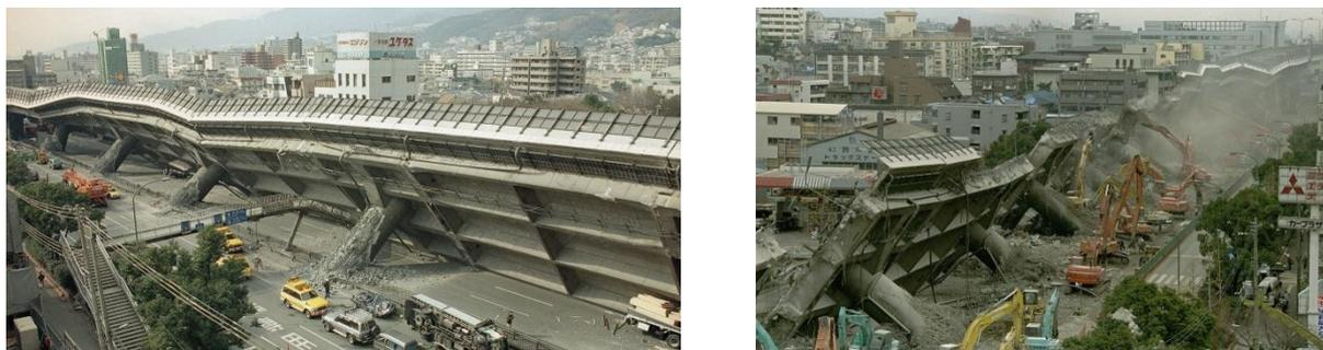
Рис. 2. Повреждение моста в Хигисина во время землетрясения в префектуре Хёго Нанбу (Япония, 1995 г.).
